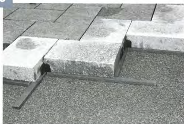
Das Setzen der Steine im Ellbogenverband ist zeitintensiv, beruht aber auf demselben Prinzip
