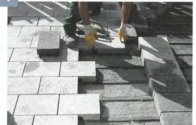
Anschließend wird der Abstandhalter zwischen die Kopffuge gesetzt. So ist der Stein von vier Seiten eingefasst
